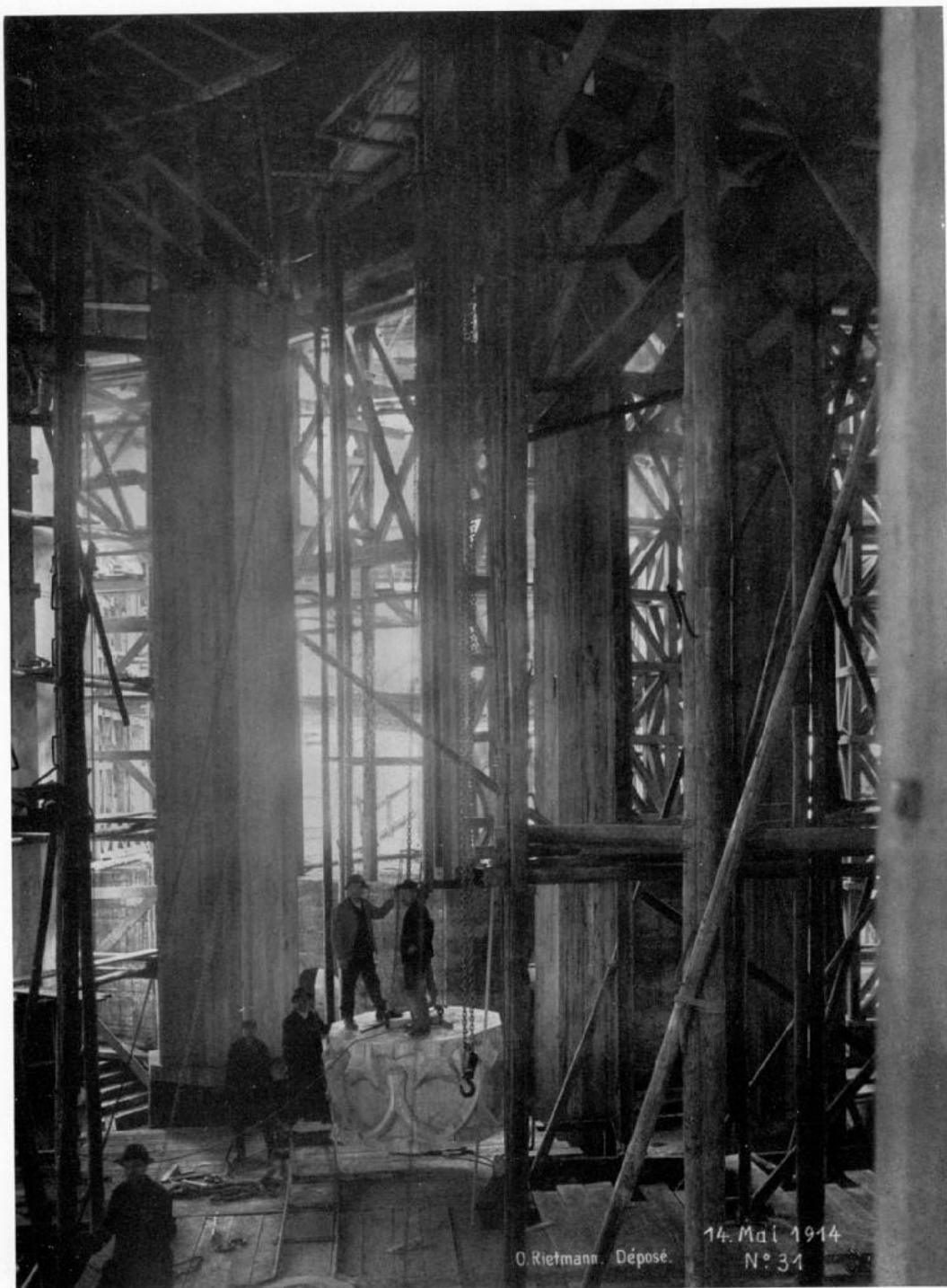
Kapiteelide paigaldamine sammastele
